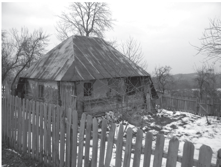
Fig. 3. Conac din satul Cracu Muntelui, Comuna Ponoare județul Mehedinți. Prezintă împrejmuire de tipul gardului de blăni, realizate la rindea. Se poate observa, în planimetria acestuia, spațiul adosat, cu acoperiș într-o apă, având rolul de adăpost pentru efectivele de ovine ale familiei. Denumirea specifică este de șatră (conac cu șatră). Inițial, pentru realizarea învelitorii s-a folosit șita de fag.
