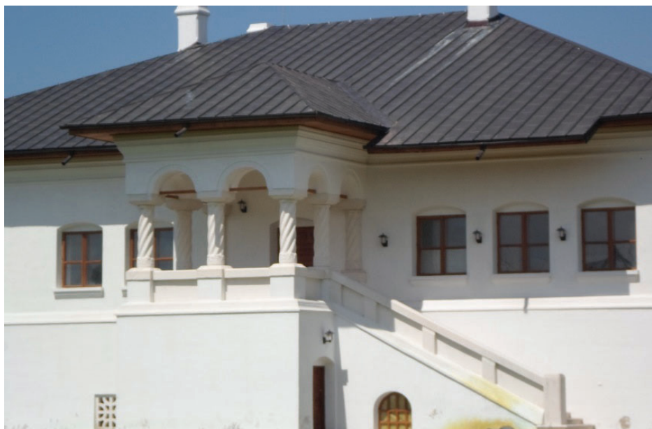
9. Foișorul casei banului Cornea Brăiloiu din Vădeni (detaliu fațadă de est).
