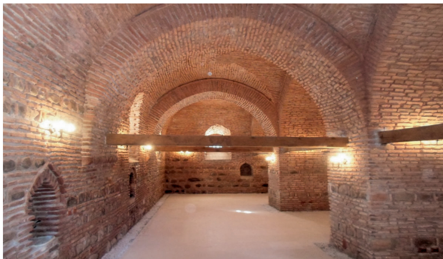
12. Beciul (pimnița) casei Cornea Brăiloiu din Vădeni – sfârșitul sec. al XVII-lea (restaurare recentă).
